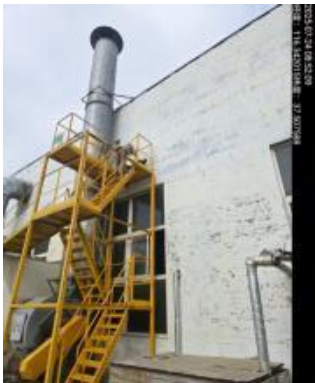
DA005 电著烤漆+橡胶条 +弹性绳包芯共用挥发性 有机物废气排气筒处理设施前
