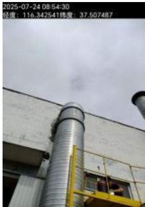
DA005 电著烤漆+橡胶条 +弹性绳包芯共用挥发性 有机物废气排气筒处理设施前
